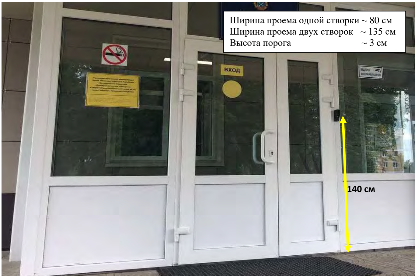
Рис.8. Входная дверь в здание. Табличка Брайля. Противоскользящие коврики
