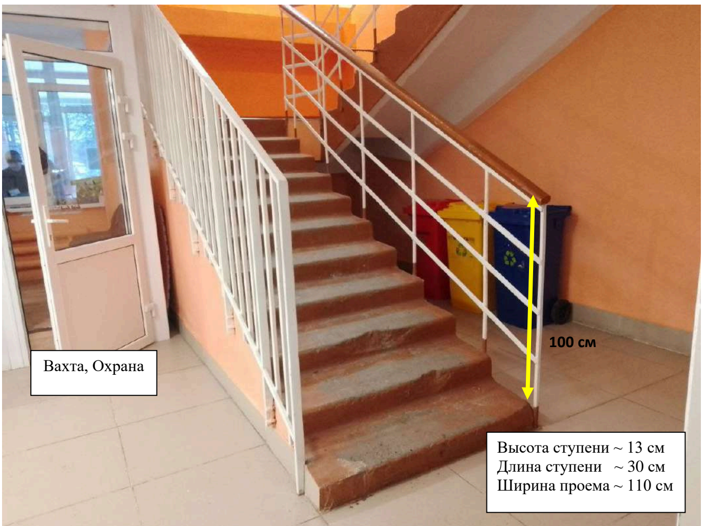
Рис.11. Лестница ведущая на первый этаж
