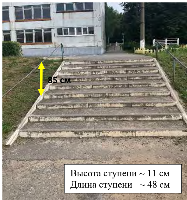
Рис.3.1. Лестница на территории школы на пути ко входу школы
