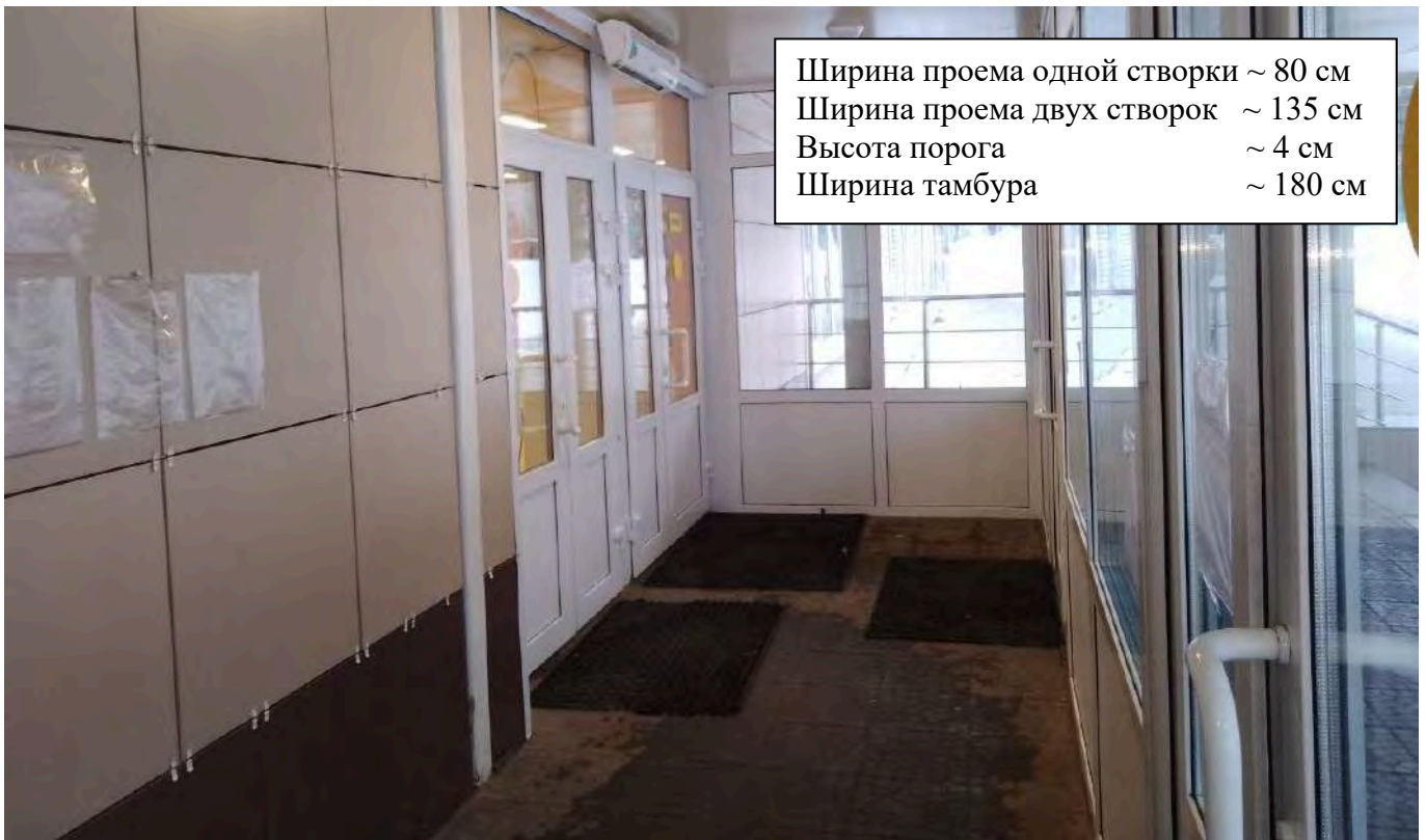
Рис.9. Тамбур. Оборудован противоскользящими ковриками и теплообменником.
