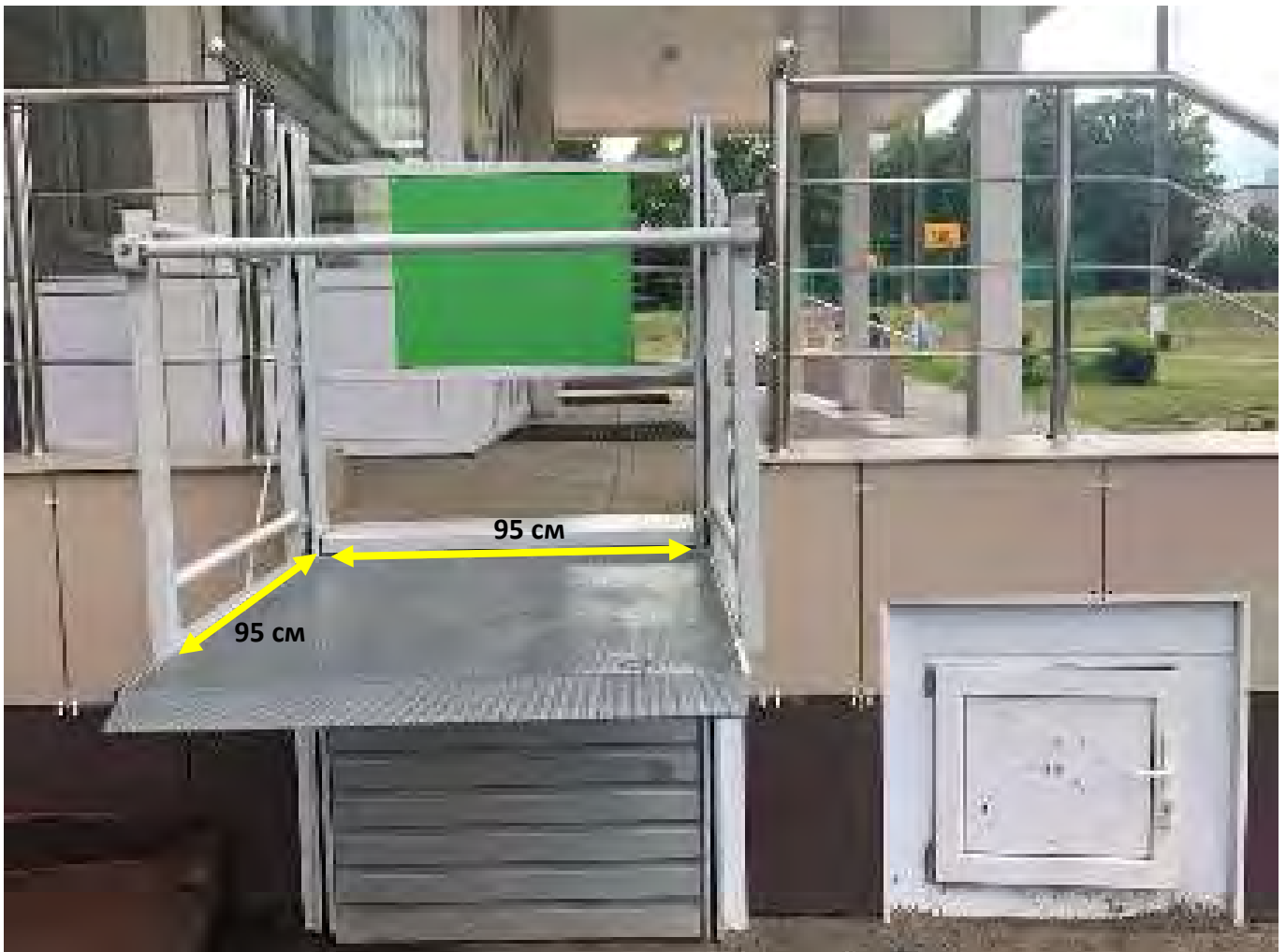
Рис.7. Электроподъемник на центральном входе
