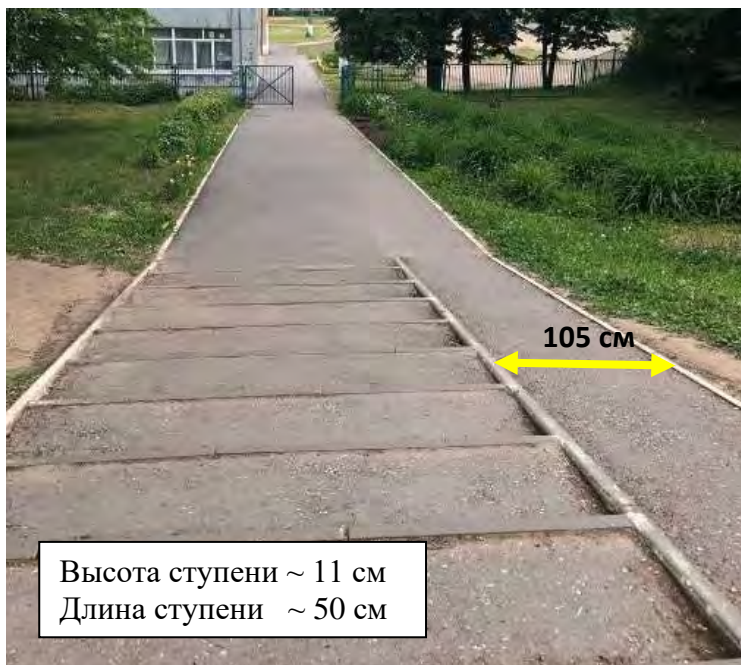
Рис.3. Вход со стороны остановки «Эльменя» Лестница без поручней
